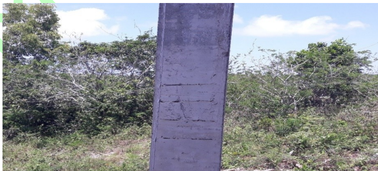
Gambar 3. Tulangan Sengkang yang Terlihat Di Permukaan
