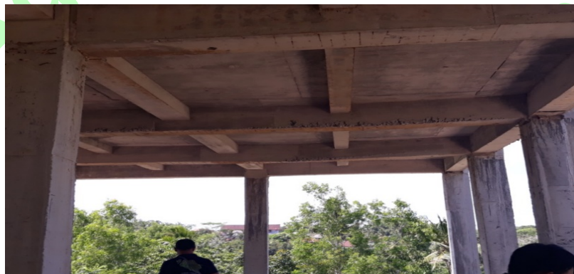
Gambar 7. Balok Yang Terlihat Melendut
