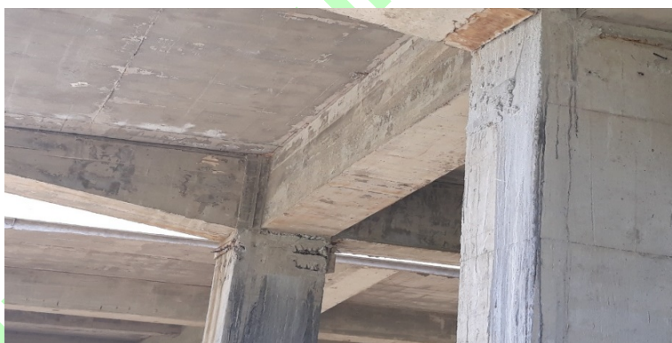
Gambar 3. Tulangan Sengkang yang Terlihat Di Permukaan
