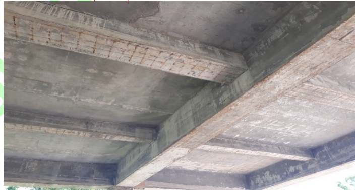
Gambar 5. Terlihatnya Tulangan Senggang dari Permukaan Balok
