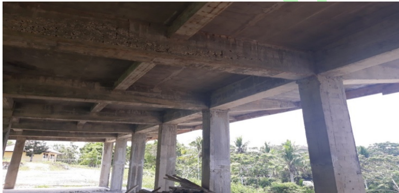
Gambar 6. Adanya Keropos Pada Beton Balok
