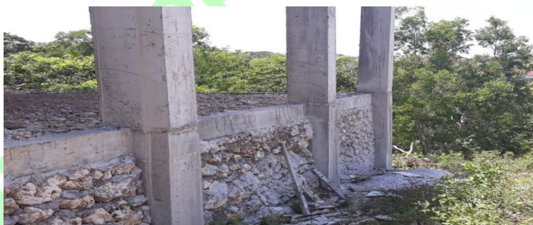
Gambar 2. Sloof dan Pondasi pada SMAN SATU ATAP NUSA PENIDA
