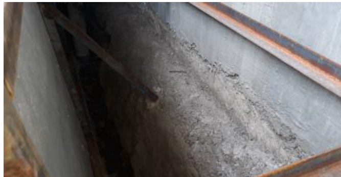
Gambar Terlihat bagian pondasi yang tidak diplester
