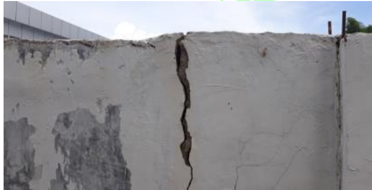
Gambar Cacat retak dinding pagar sebagai akibat tidak terpasangnya tulangan baja pada komponen sloof dan ringbalk
