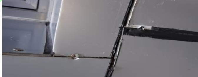
Gambar Terlihat skrup untuk menggantung ACP ke rangka besi siku
