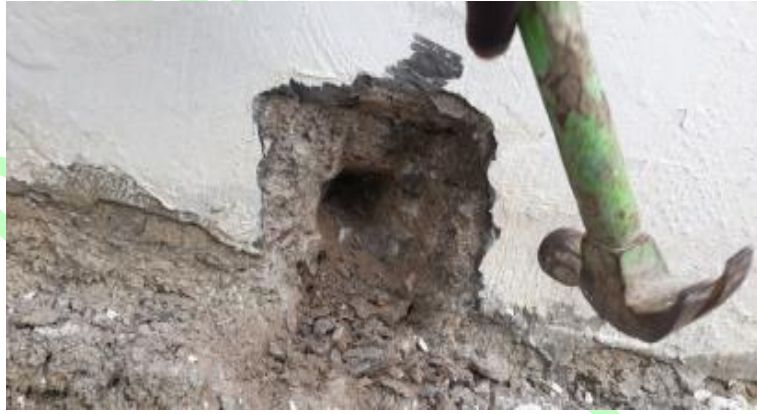
Gambar 13. Bagian sloof pagar yang tidak ditemukan tulangan baja
