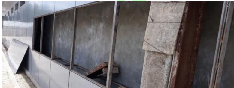
Gambar : Terlihat dinding eksterior tidak terlapisi cat dinding 2.
