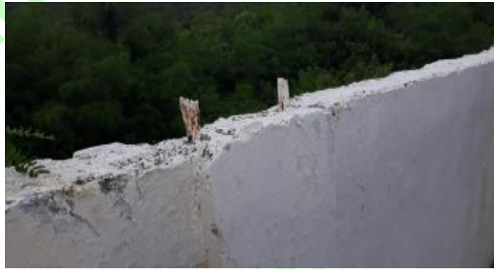
Gambar. Tulangan kolom tidak terpasang sesuai pola dalam gambar perencanaan
