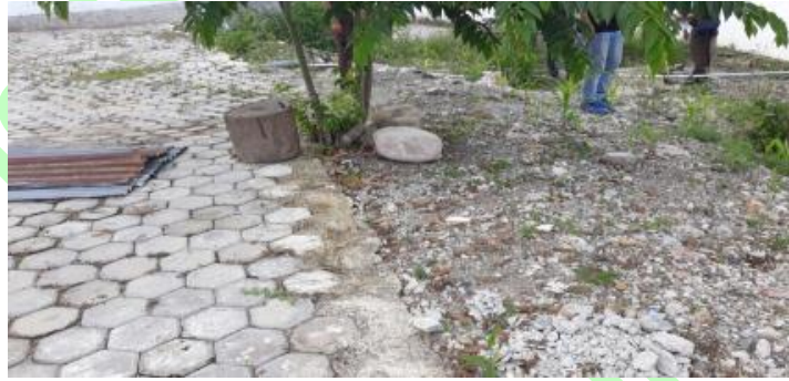
Gambar Terlihat bagian beton pengancing (kansteen) pasangan paving block yang dikerjakan secara asal – asalan.
