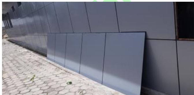
Gambar Terlihat penggunaan sealent tidak pada tempatnya
