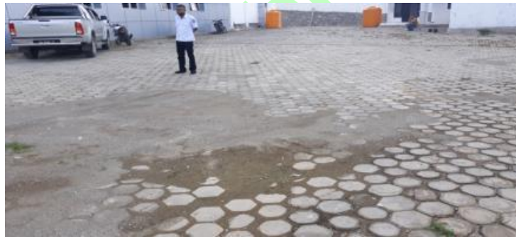
Gambar Sebagian paving block sudah rusak, permukaan tidak rata.
