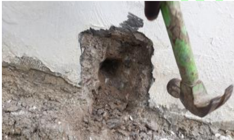
Gambar 13. Bagian sloof pagar yang tidak ditemukan tulangan baja
