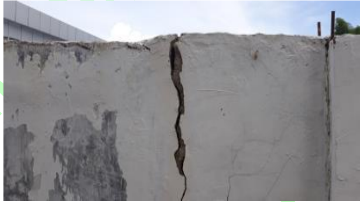
Gambar Cacat retak dinding pagar sebagai akibat tidak terpasangnya tulangan baja pada komponen sloof dan ringbalk 3.
