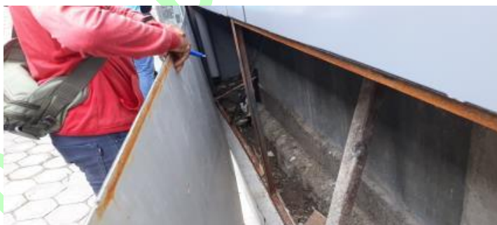
Gambar Tampak rangka ACP dari jenis besi siku dengan kondisi berkarat
