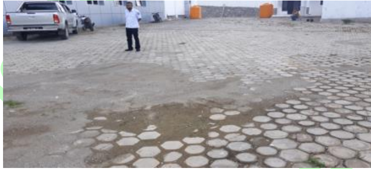
Gambar Sebagian paving block sudah rusak, permukaan tidak rata.
