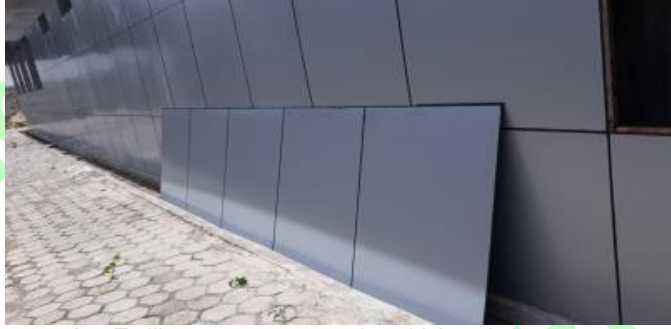
Gambar Terlihat penggunaan sealent tidak pada tempatnya
