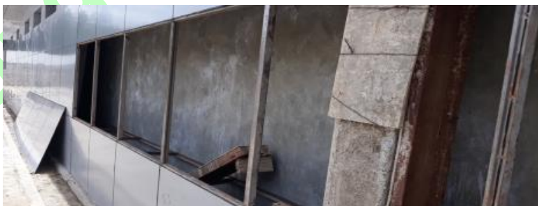
Gambar : Terlihat dinding eksterior tidak terlapisi cat dinding
