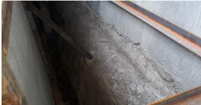
Gambar Terlihat bagian pondasi yang tidak diplester
