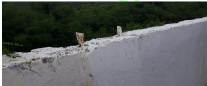
Gambar Cacat retak dinding pagar sebagai akibat tidak terpasangnya tulangan baja pada komponen sloof dan ringbalk 4.
